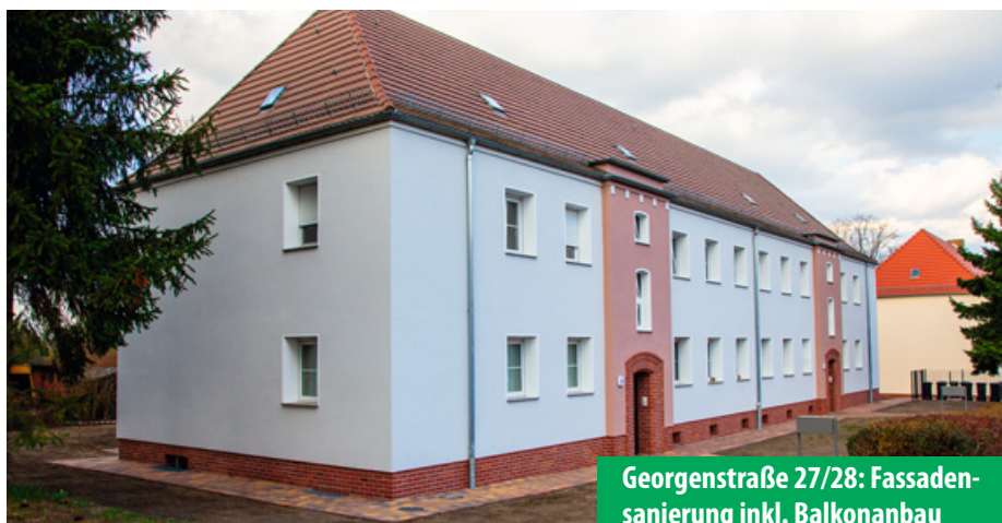
Die Sanierungsarbeiten in der Georgenstraße konnten 2025 abgeschlossen werden.
