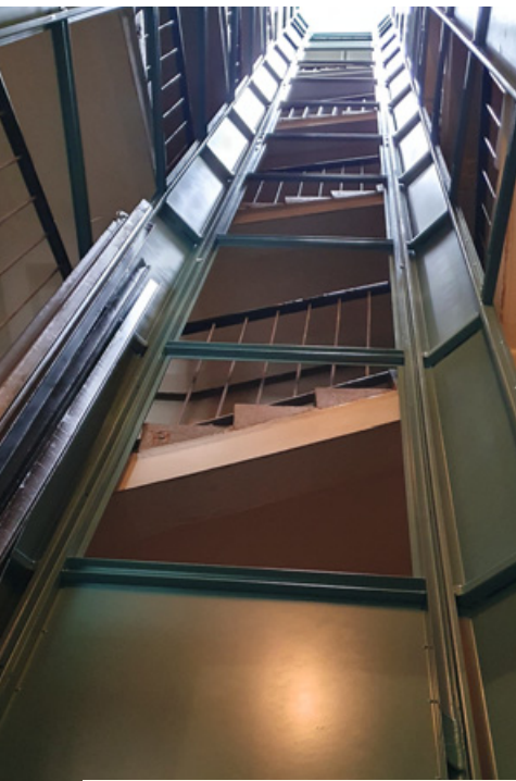
Ein Aufzugsschacht wird eingebaut
