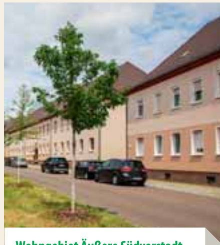
Wohngebiet Äußere Südvorstadt Glück Auf, Kraftwerkstraße, Knappen- und Steigerweg
