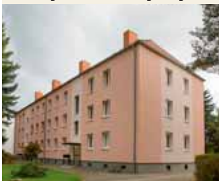
Gereinigte Fassade im Steigerweg 1/2
