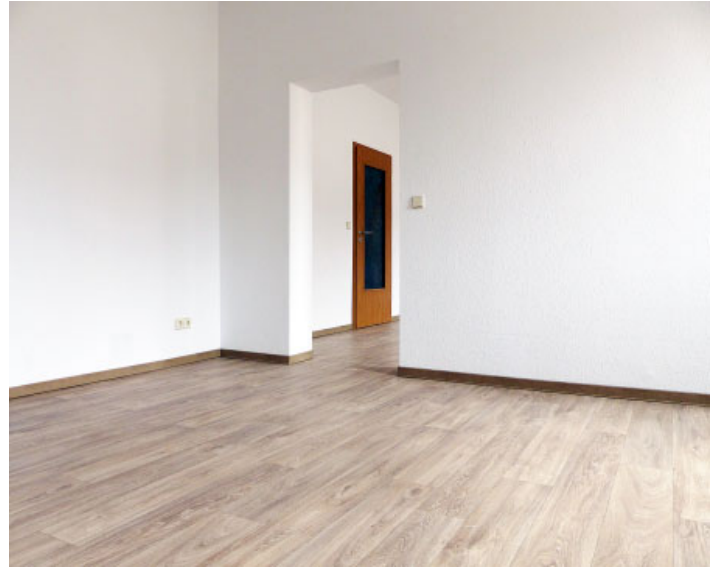
Die neu aufgebauten Fußböden sind mit einer 3-Millimeter-Trittschalldämmung und hochwertigem PVC-Belag versehen.
